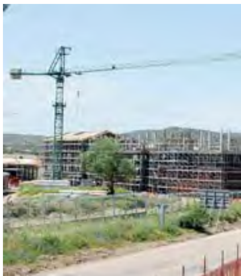
Un cantiere edile
